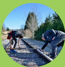
Il faut également **vérifier** les **traverses, éclisses, selles, tirefonds**, et autres **boulons...** et remplacer tout matériel défectueux. Le **graissage des aiguilles** est aussi important pour faciliter les manœuvres, tout comme la protection contre la neige grâce à des planches en bois sur les aiguilles.
