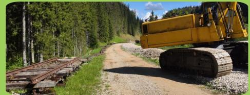
Il y a tout d'abord l'**entretien des voies** actuelles. Ici il faut **regarder l'écartement des voies**, qui est à **1435mm** sur notre réseau. Pour cela une **règle d'écartement** est de mise, et une mesure tous les **5,5m** est nécessaire.
